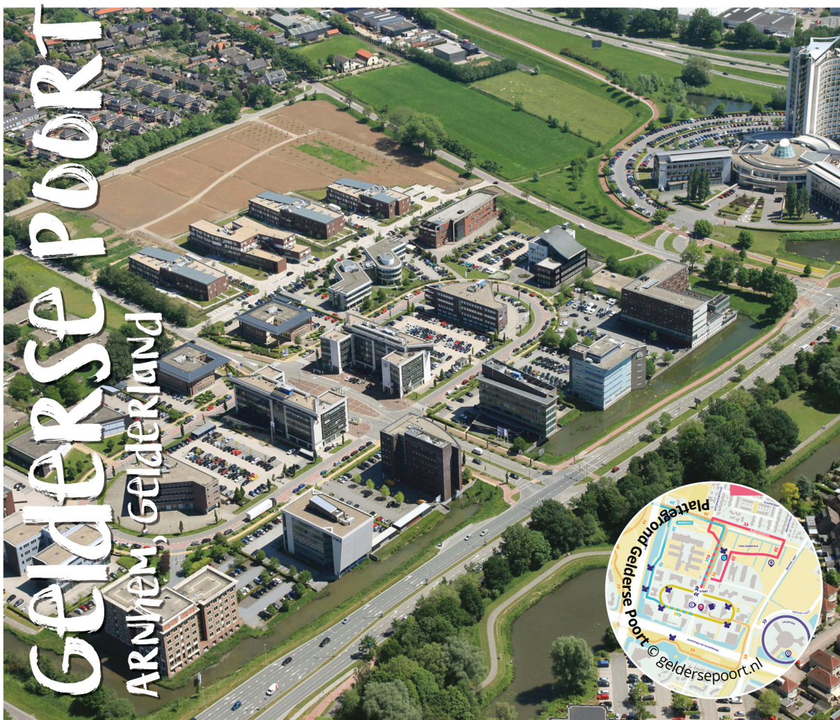
Luchtfoto Gelderse Poort © geldersepoort.nl
